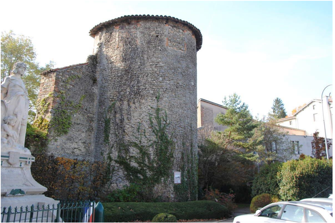
Montluel, reste de l'enceinte médiévale (Photo E. Coux)
