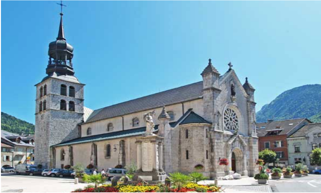
10. Eglise paroissiale Saint-Maurice, à Thônes (clocher reconstruit après 1815)
