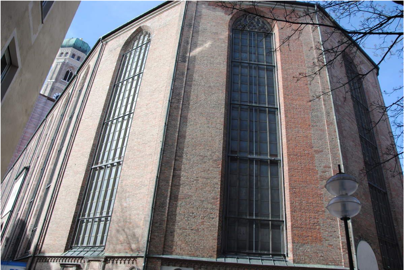
Abside de l'actuelle cathédrale de Munich. Il n'y a aucuns contreforts (Photo E. Coux)
